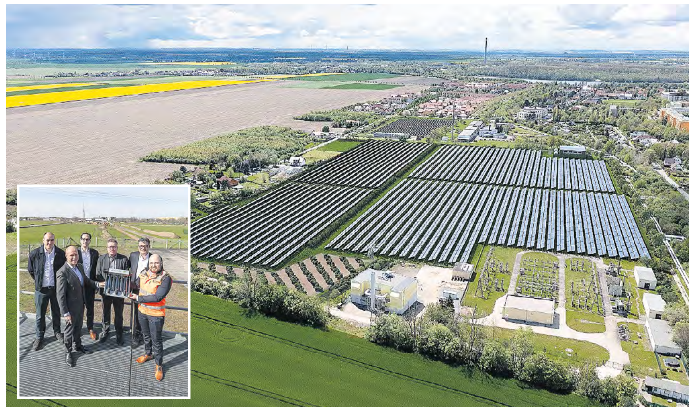
Blick in die nahe Zukunft: So soll die Solarthermie Leipzig-West einmal aussehen. Begleitet worden ist der Baustart (kleines Foto, v. l.) von Paul Gaspar (Projektleiter Ritter), Karsten Rogall und Dr. Maik Piehler (Geschäftsführer Leipziger Stadtwerke), Dr. Gerd Lippold (Energie-Staatssekretär Sachsen), Matthias Johler (Geschäftsführer Ritter) und Erik Jelinek (Leipziger Stadtwerke).
