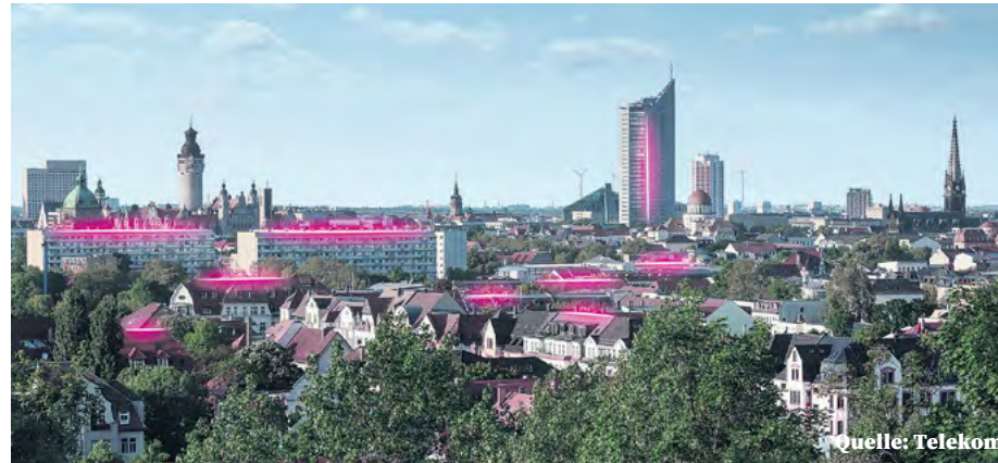
Für rund 110.000 Haushalte in Leipzig baut die Telekom Glasfaserleitungen aus.
