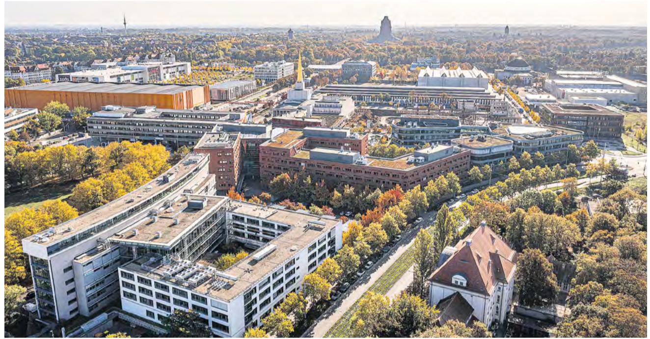
Großes Wachstumspotenzial: Die Bio City auf dem Alten Messegelände bekommt in Halle 12 durch eine umfangreiche Sanierung bald zusätzliche Flächen für Neuansiedlungen und Erweiterung bestehender Unternehmen. Foto: Philipp Kirschner
