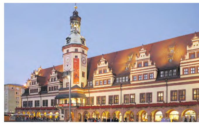
Denkmal-Stars ins Rampenlicht: Auch das Alte Rathaus, gebaut 1556/1557 unter Leitung des damaligen Bürgermeisters Hieronymus Lotter, gehört dazu. Foto: LTM/Andreas Schmidt
