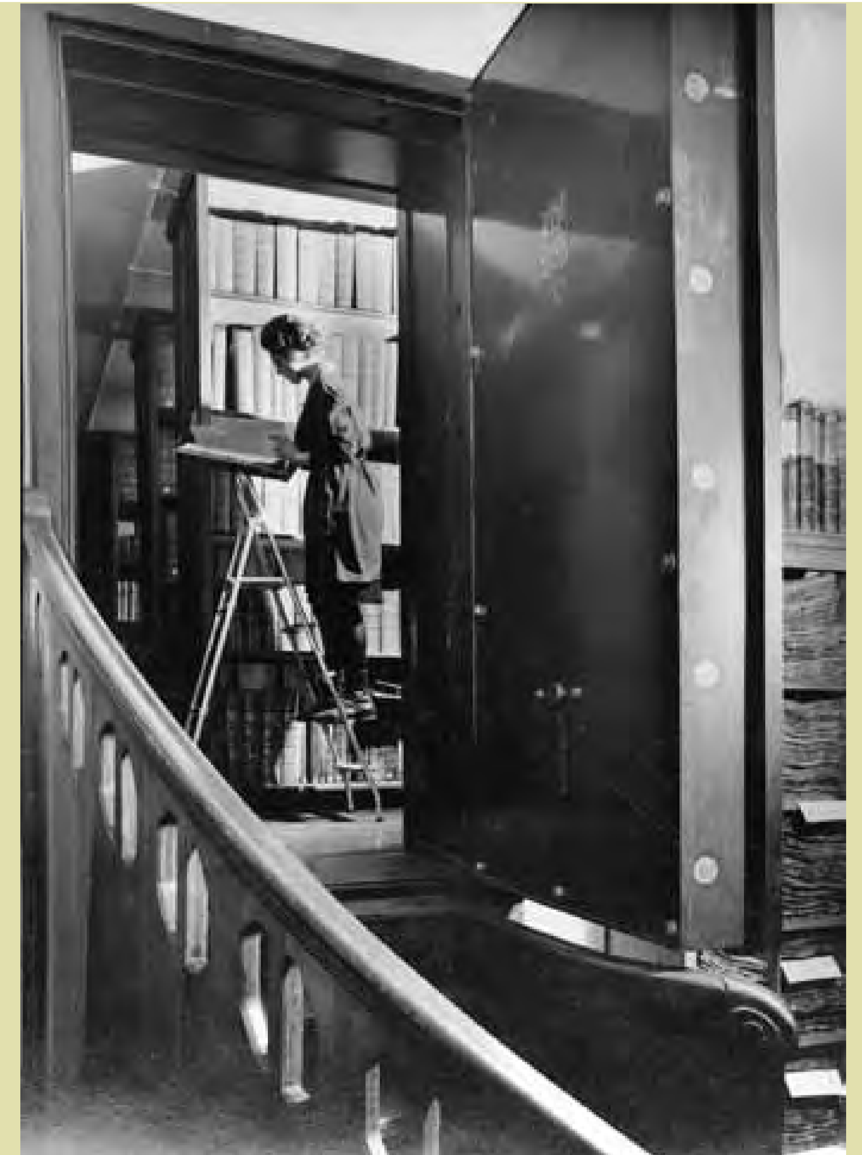
Eingang zum Tresorraum der früheren Stadtbank im Stadthaus, in dem 1924 - 1994 die Urkunden und Stadtbücher untergebracht waren, 1968
