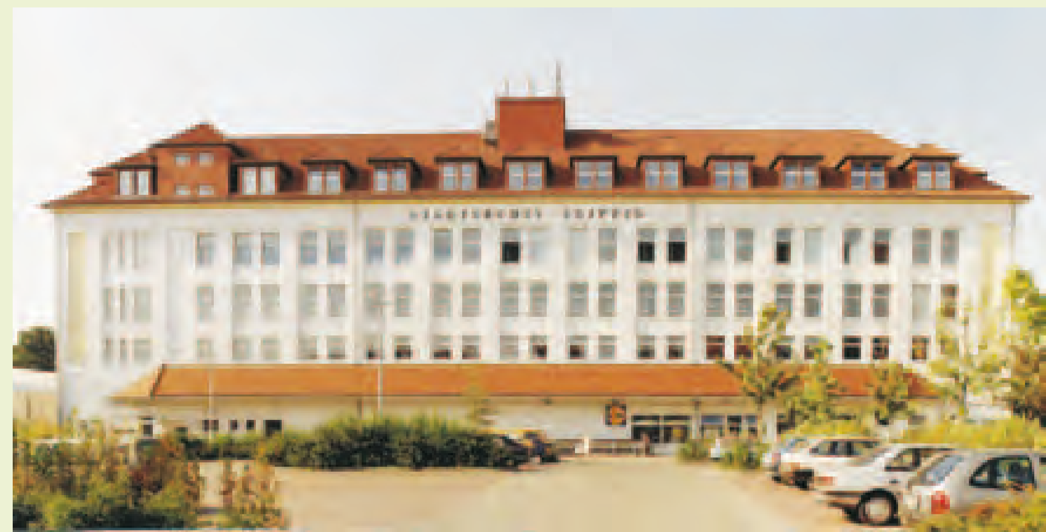
Außenansicht Torgauer Straße, 1996
