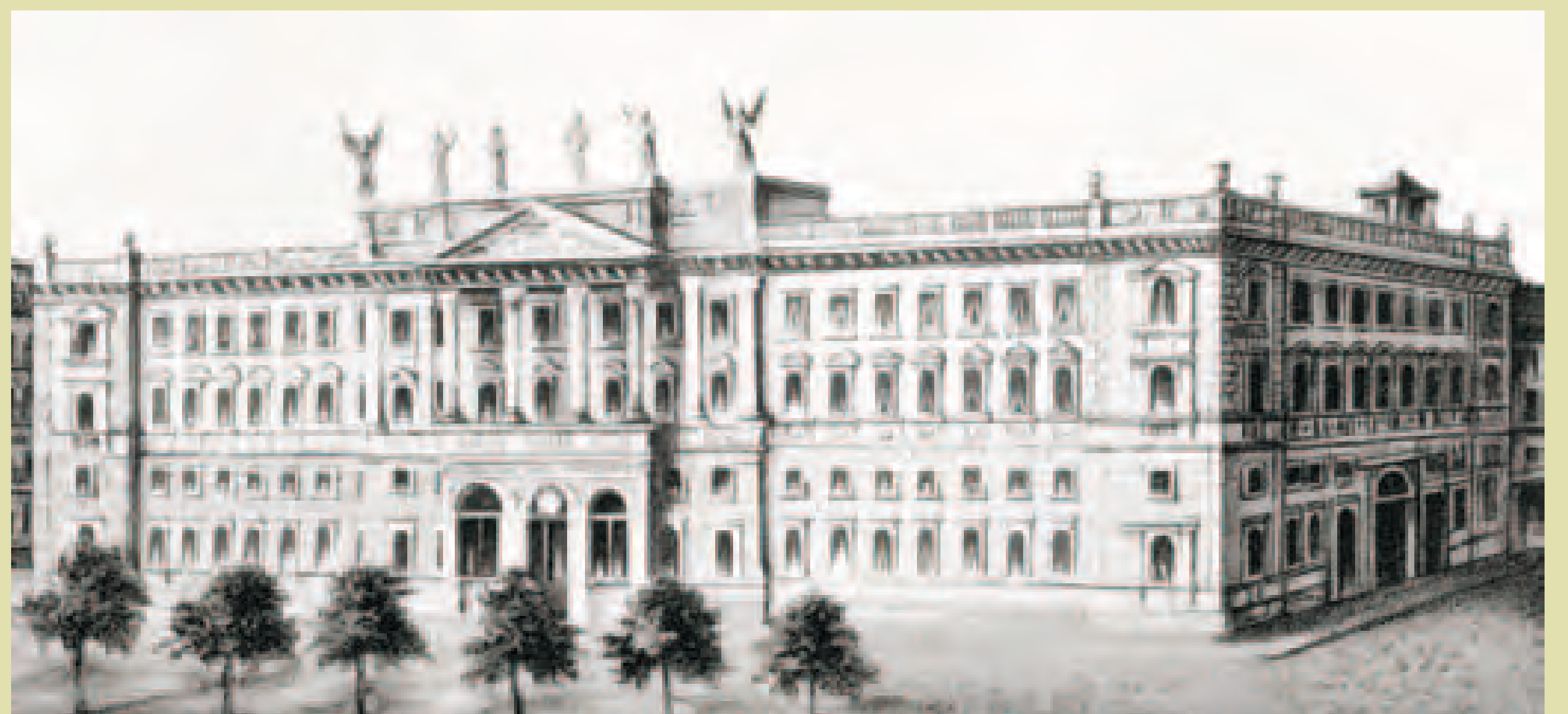
Die Hauptpost vor dem Umbau, 1870 und nach dem Umbau, 1883 (rechts)
