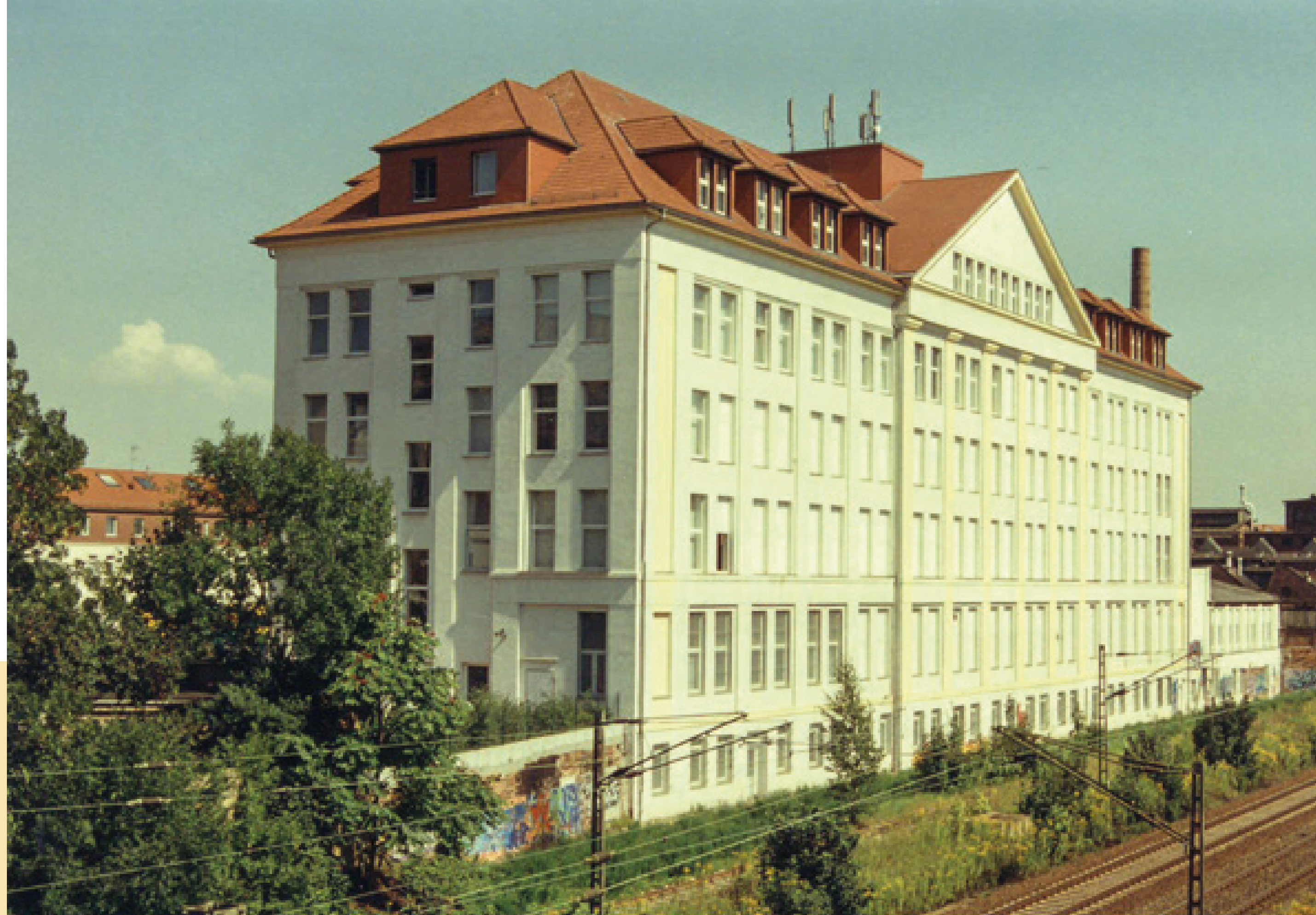
Am 9. August 1994 wurde das neue Stadtarchiv in der Torgauer Straße 74 feierlich eingeweiht. Abb. S.-M. Plath, 1994, Fotografie, StadtAL.
