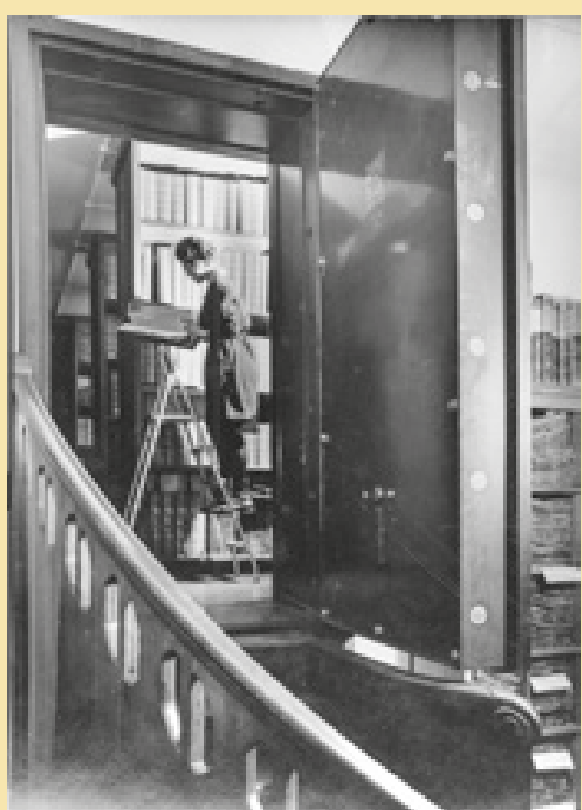
Eingang zum Tresorraum der früheren Stadtbank im Stadthaus, in dem zwischen 1924 und 1994 die Urkunden und Stadtbücher untergebracht waren. Abb. S.O. Müller und P.K. Jericke, 1968, Fotografie, StadtAL.
