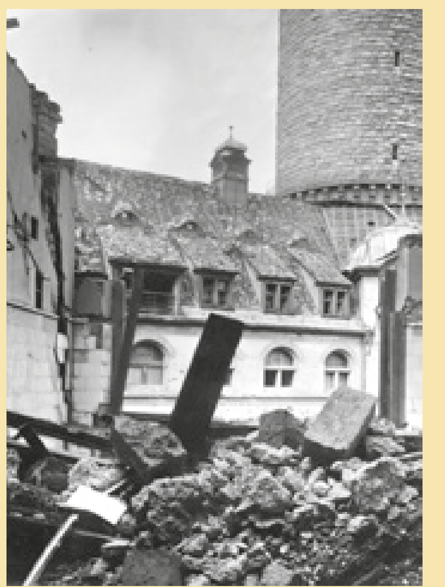
Kriegsbedingte Zerstörungen, Blick in den Großen Hof des Neuen Rathauses. Abb. H. Lindner, 30. Mai 1945, Fotografie, StadtAL.
