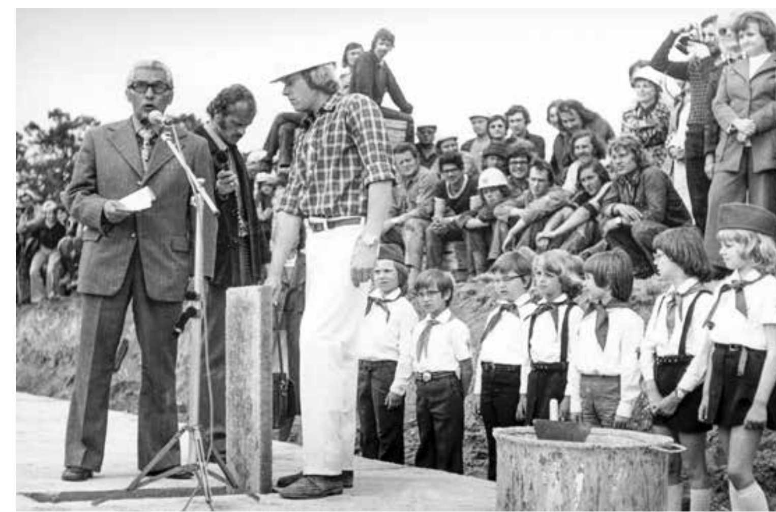
Grundsteinlegung für das Wohngebiet Leipzig-Grünau durch den Oberbürgermeister Dr. Karl-Heinz Müller am 1. Juni 1976, Foto Karla Voigt, 1. Juni 1976, StadtAL, Bildarchiv.
