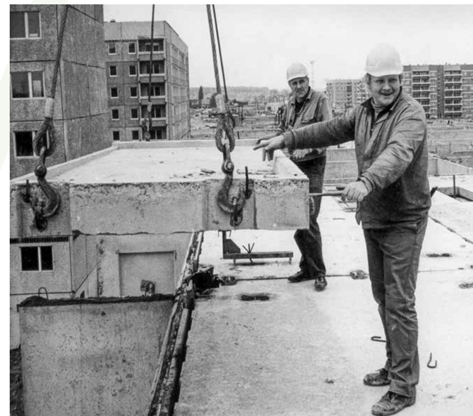
Wohngebiet Leipzig-Grünau, Montage von Großplatten an einem Wohnblock durch die Jugendbrigade „Hans Beimler“ im Wohnkomplex 8, Foto Peter Krebs, 30. Juli 1986, StadtAL, Bildarchiv.
