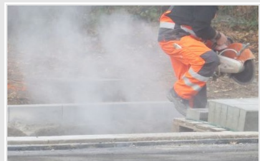
Abb. 52. Staubintensiver Trockenschnitt von Steinen als typischer Arbeitsgang auf Baustellen.
