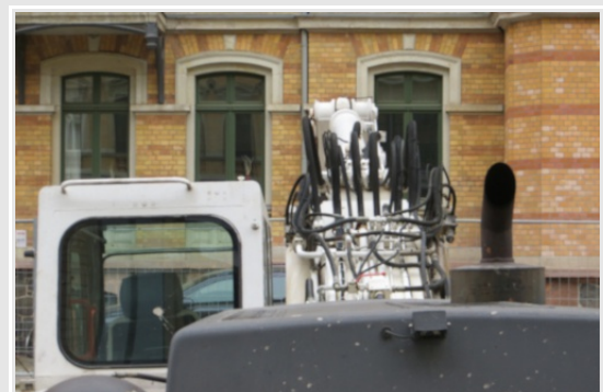
Abb. 54. Baumaschine vor einem Wohngebäude.
