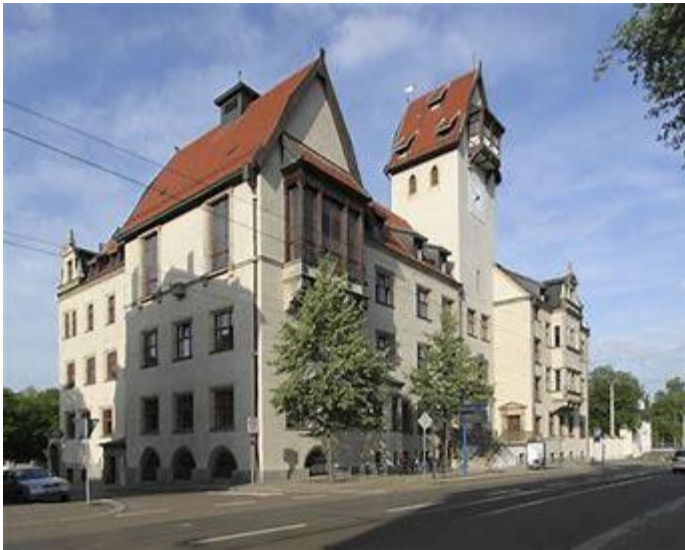
Quelle: Architektenbüro Klaus Nauber
