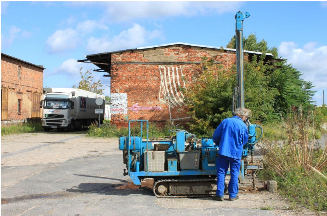
**Bild 4:** Kampfmittelsondierbohrung am Bohrpunkt BS 4
