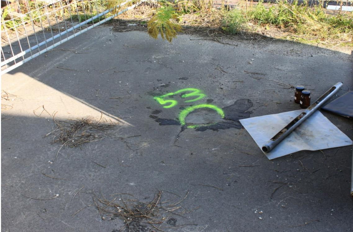
**Bild 5:** Bohrpunkt BS 53 nach Verschließen des Bohrloches mit Mörtel
