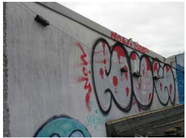
Halle 21, Dachverblechung mit pot. Zwischen- und Sommerquartiereigenschaften
