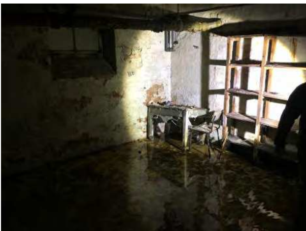
Halle 21: 2 Keller, pot. mit Winterquartier-eigenschaften aber ohne Besiedlung
