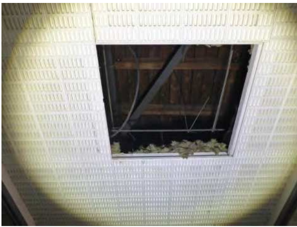
Halle 21, Zwischenboden mit Dämmwolle : pot. Fledermausquartiereigenschaften
