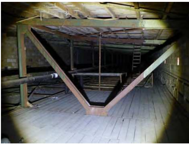
Dachboden Halle 17, keine Einflugmöglichkeiten, ohne Befund
