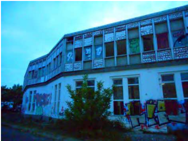
Mauersegler Nistplätze, Halle 21
