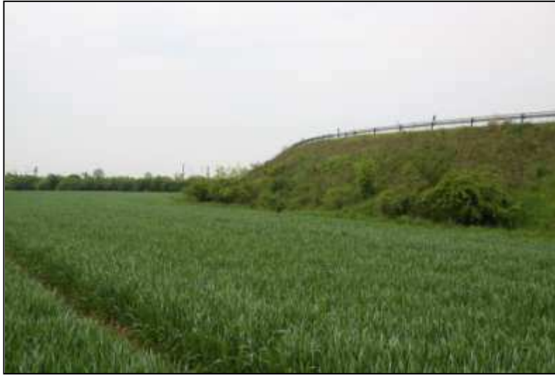
Foto 10: Straßenböschung der K6570 am Westrand des UG. Brutplatz von Dorngrasmücke und Sumpfrohrsänger.
