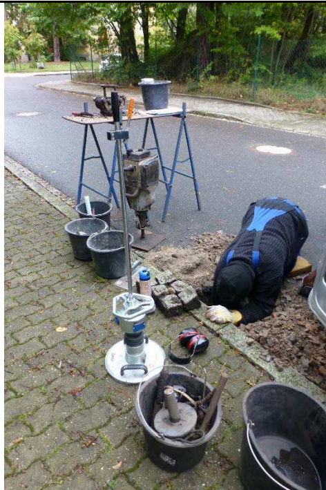
Foto Nr. 4: Durchführung Schurfarbeiten Schurf 3/16
