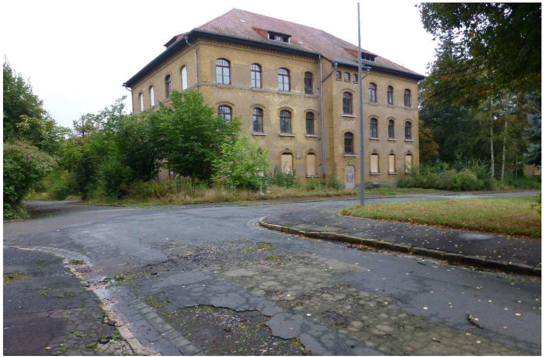
Foto Nr. 3: Situation im Bereich Schurf 4/16
