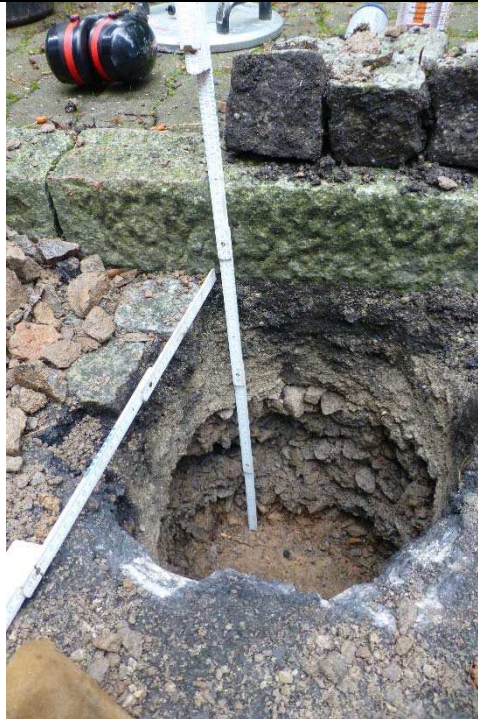
Foto Nr. 5: Schurf 3/16 Asphalt und Schottertragschicht, Planum: Geschiebelehm
