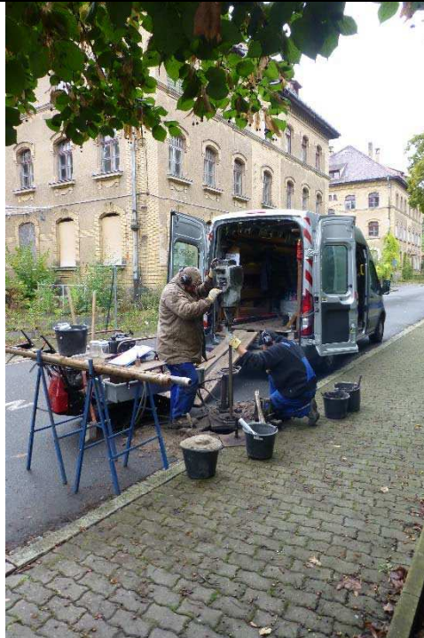
Foto Nr. 7: Durchführung der Rammkernsondierung RKS 3/16
