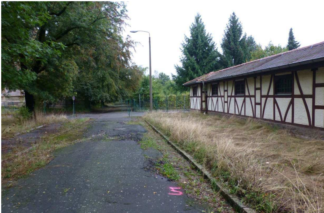
Foto Nr. 2: Vorortsituation im Bereich Schurf 5/16
