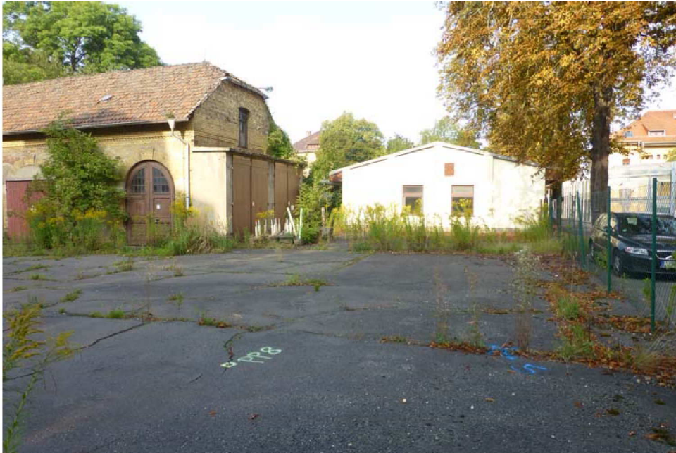
Foto 1: Situation mit Bestandsgebäude im östlichen Bereich des geplanten Parkhauses Nord, Vordergrund Ansatzpunkt RKS 5/17
