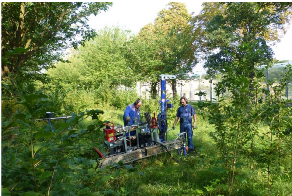
Foto 10: Durchführung Sondier- arbeiten RKS 3/17
