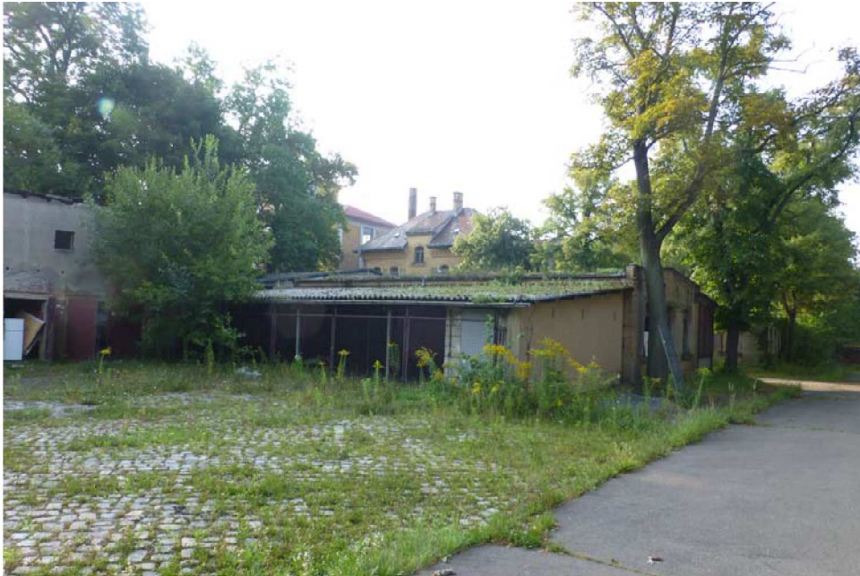
Foto 3: Ist-Situation im Bereich des zukünftigen Gebäudes N4, die vorhandenen Flachbauten werden abgeris- sen
