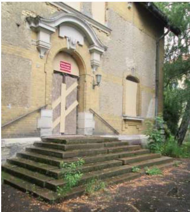
Abb. 20 Haupteingang des Hauses C1
