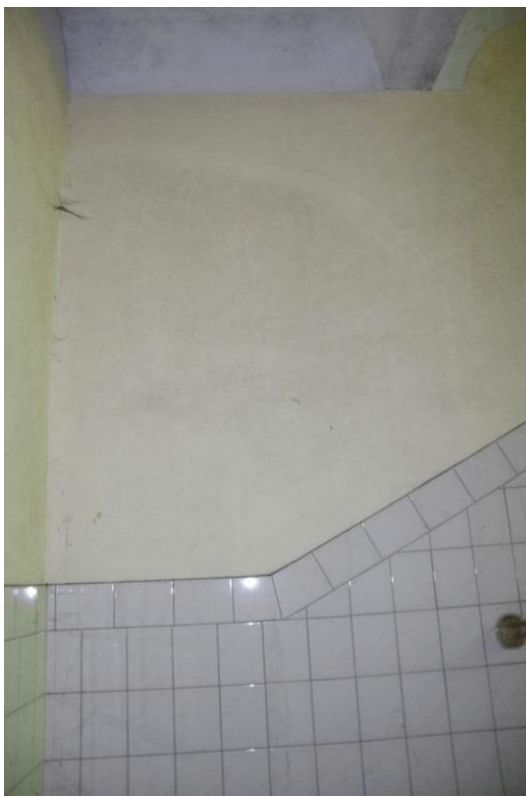
Podestebene EG mit vermauerter Bogenöffnung
