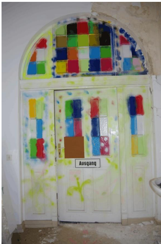
bauzeitlich erhaltene Tür zum Nebentreppenhaus
