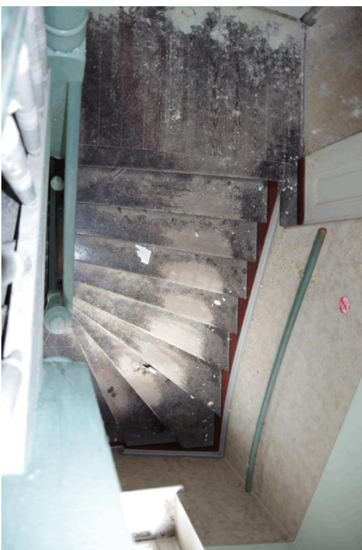
Treppenlauf mit Zwischenpodest
