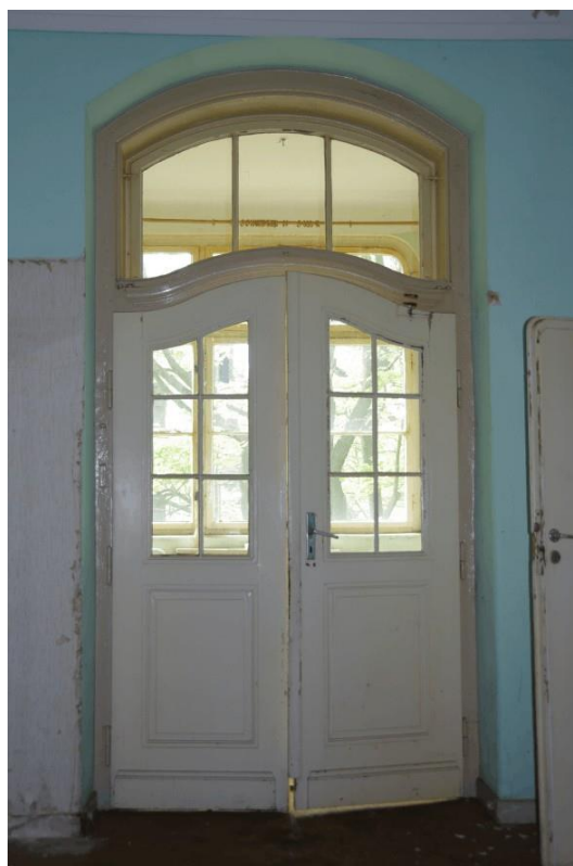
Detail bauzeitlich erhaltene Verandatür
