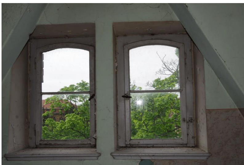
Südfassade / Fenster Seitengiebel
