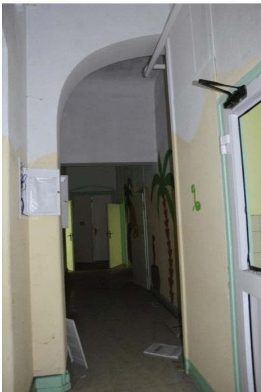
Flurbereich mit vermauerter Bogenstellung / Blickrichtung West
