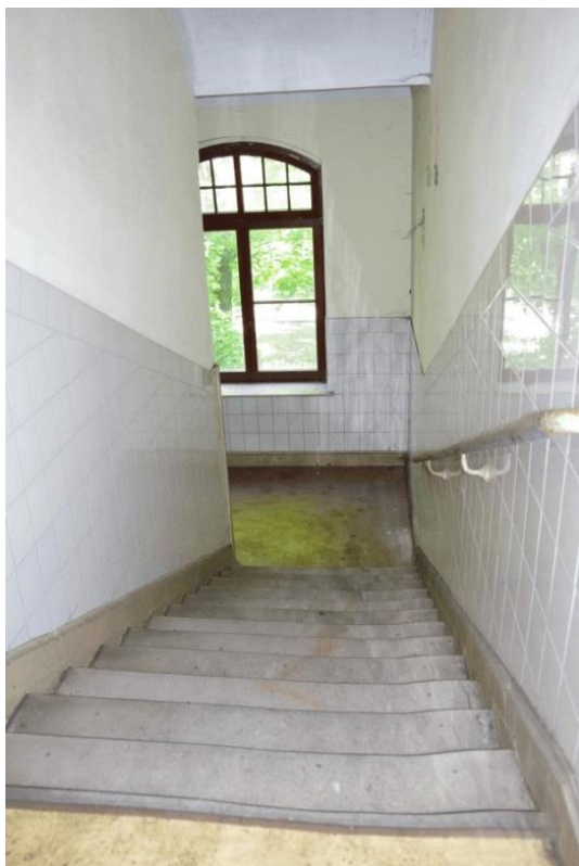
Treppenlauf EG zu 1. OG
