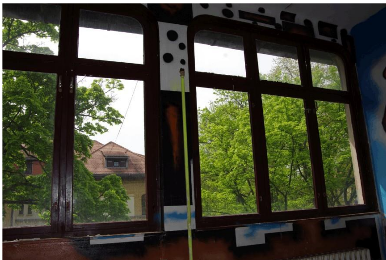
Detail westliche Verandafenster
