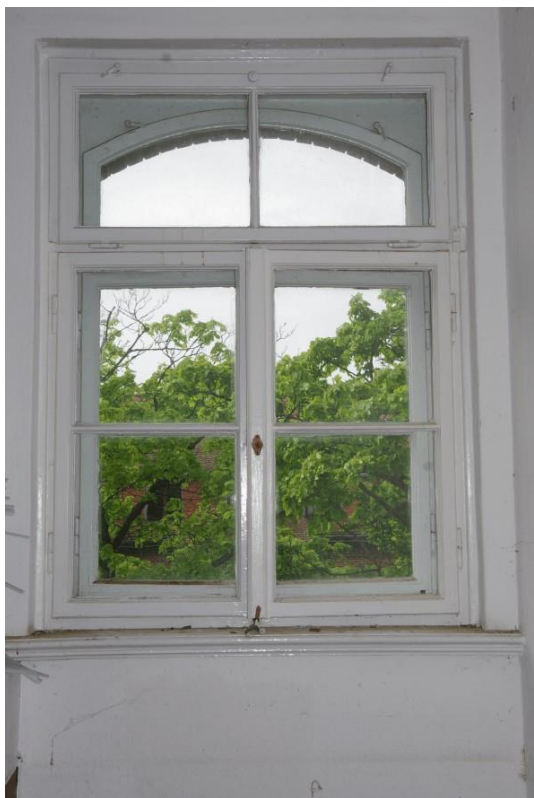
Innenraum / bauzeitlich erhaltene Kastenfenster mit Detail Fensterolive
