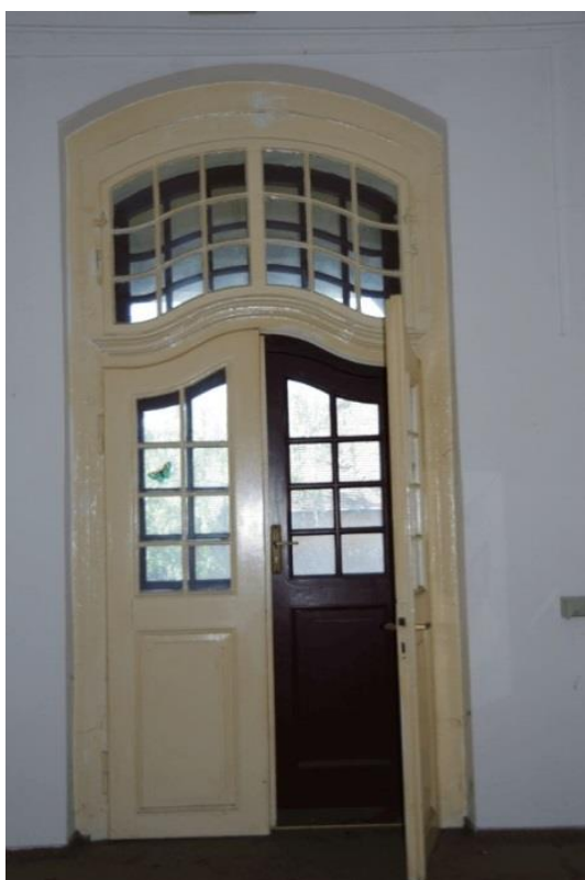
Vorraum Veranda mit bauzeitlich erhaltener Veranda - Innentür
