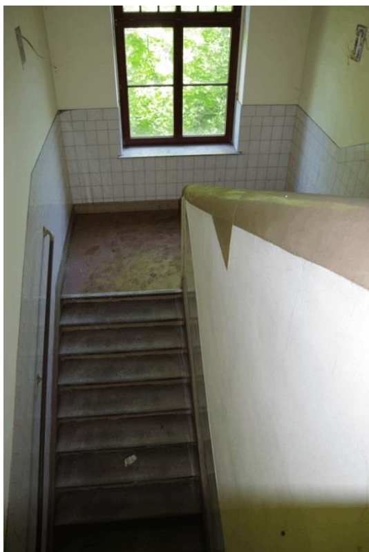
Treppenlauf 1. OG zu 2. OG
