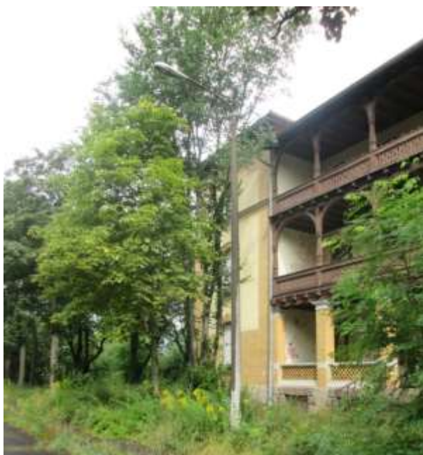
Abb. 37 Mastleuchte, die zu DDR-Zeiten in den Straßenraum integriert wurde
