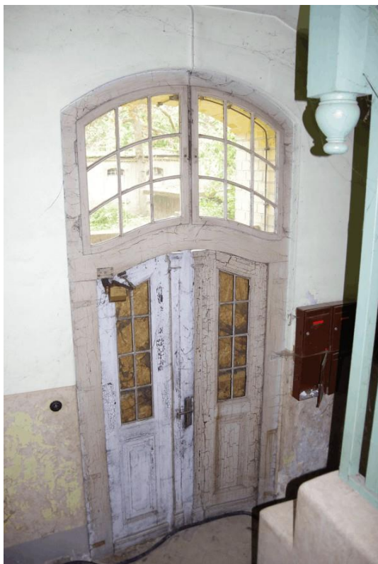
Treppenhaus im EG mit bauzeitlich erhaltener Hauseingangstür
