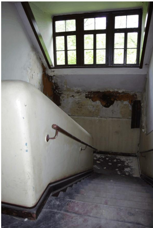
Treppenlauf DG zu Zwischenpodest
