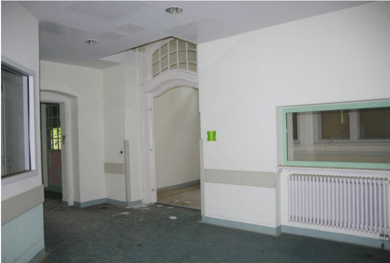
Flurbereich mit bauzeitlicher Verandatür (Rahmung und Oberlicht)
