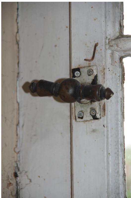
Innenraum / bauzeitlich erhaltene Kastenfenster mit Detail Fensterolive
