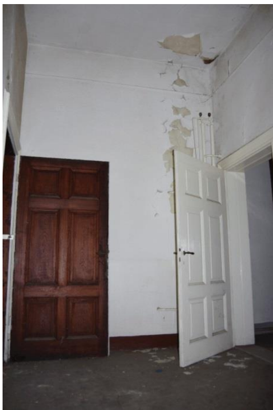
Vorraum Podestebene DG
