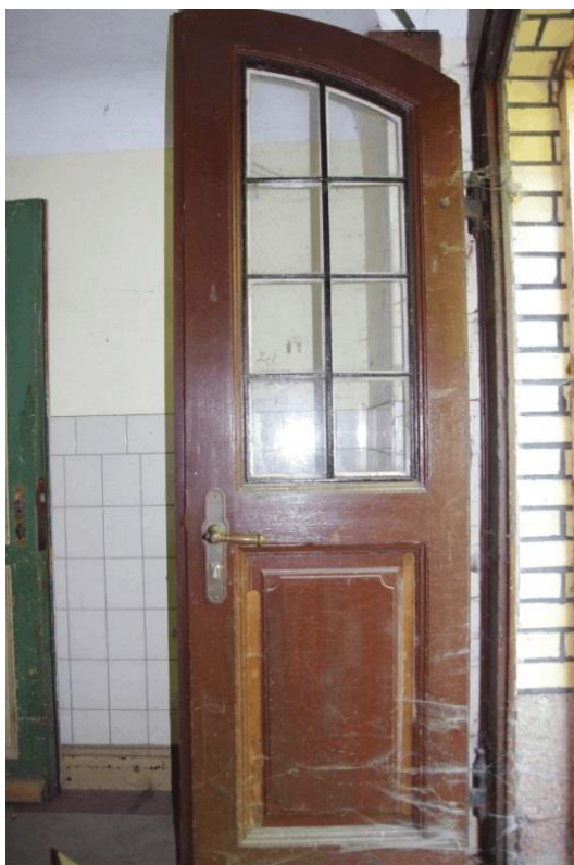
bauzeitlich erhaltene Hauseingangstür
