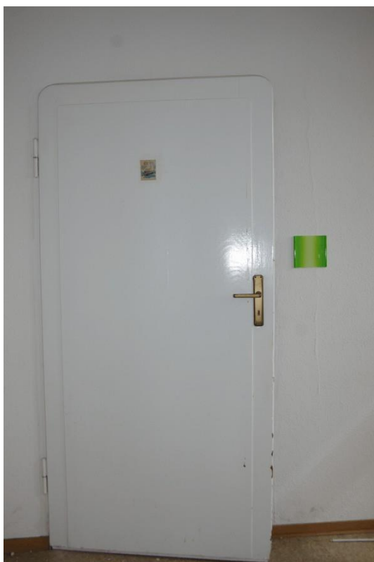
Flurbereich mit z.T. bauzeitlich erhaltenen Türen
