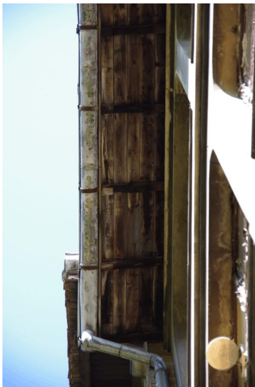
Dachkasten-Untersicht mit Traufe
