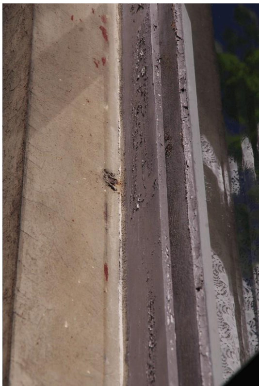
Südfassade / Detail Veranda- Fensterrahmung zu Fensterleibung
