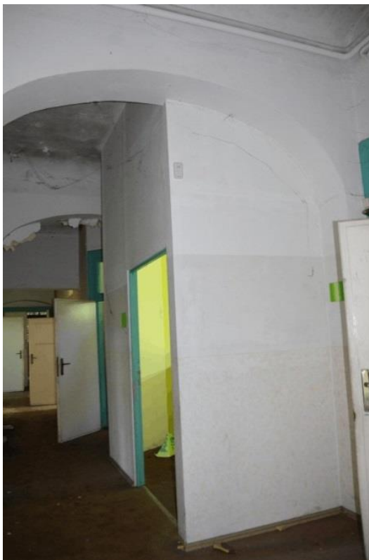
Flurbereich mit vermauerter Bogenstellung / Blickrichtung West
