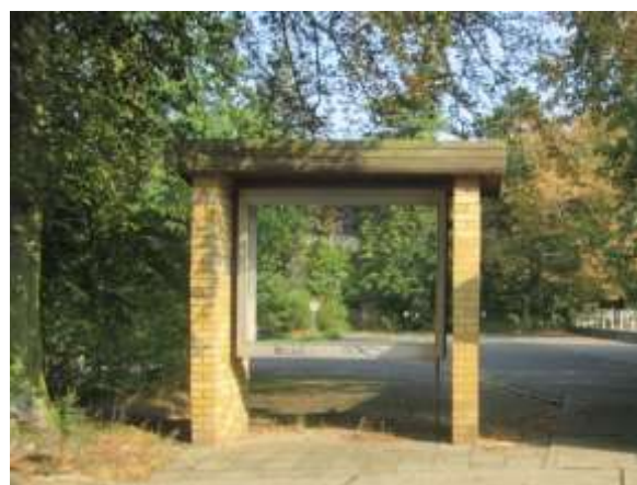
Abb. 32 Pförtnerhäuschen mit Plattenbelag im Hintergrund
