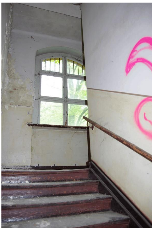
Treppenlauf mit Zwischenpodest
