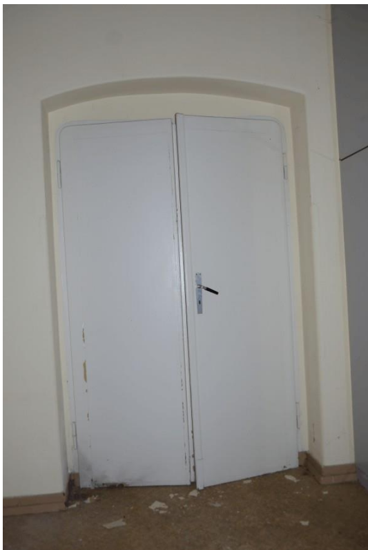
Flurbereiche / bauzeitlich erhaltene Tür/ Flurbegrenzung - Zugang Räume
