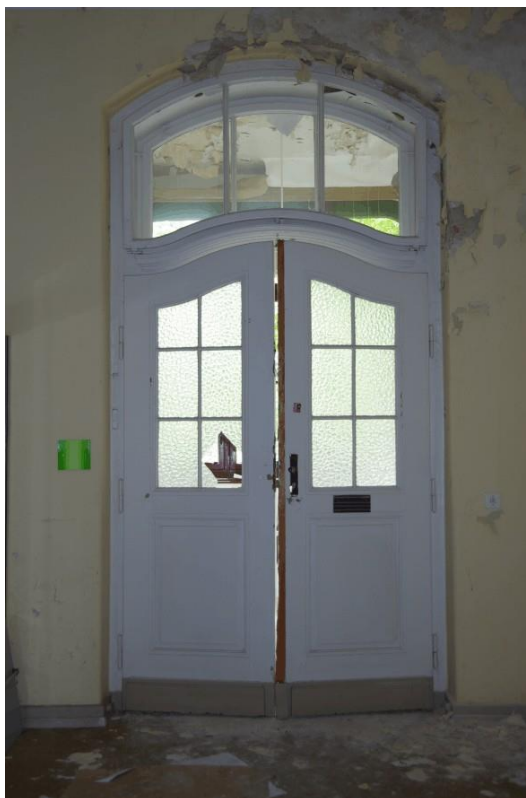
Detail Vorraum Veranda mit z. T. bauzeitlich erhaltener und reparierter Verandatür (Sprossen inneres Oberlicht erneuert)
