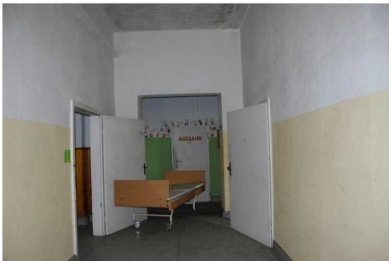
Flurbereich mit neu eingebauten Wandstellungen und Türen
