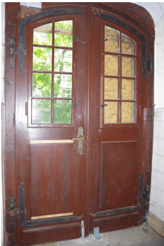
bauzeitlich erhaltene Hauseingangstür
