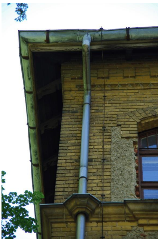
Detail Gebäudeecke 2. OG
