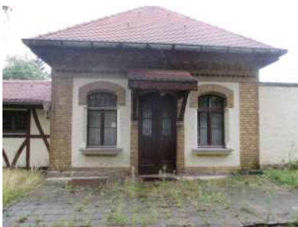
Abb. 31 Bereich vor der ehemaligen Kegelbahn mit Betonplatten
