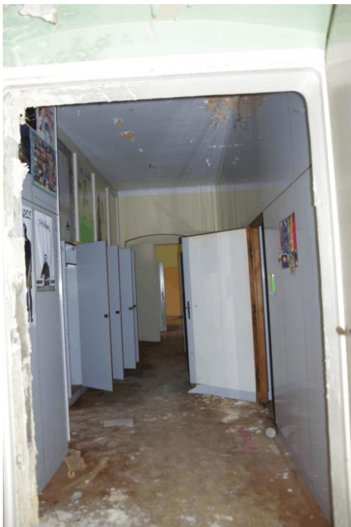
Flurbereiche mit z.T. neuen Einbauten wie Wandflächen, Deckenverkleidungen, sowie bauzeitlich erhaltenen als auch modernen Türeingbauten
