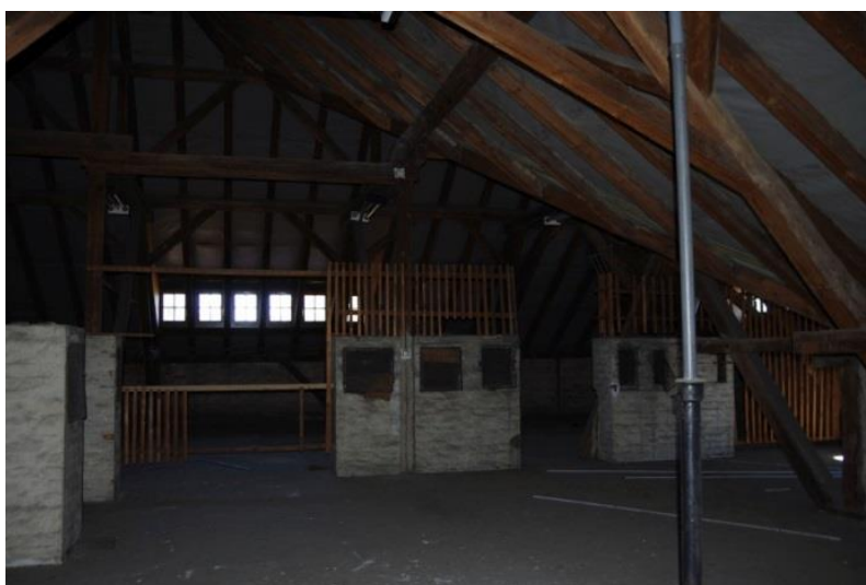
Ansicht Dachraum mit abgebrochenen Schornsteinköpfen
