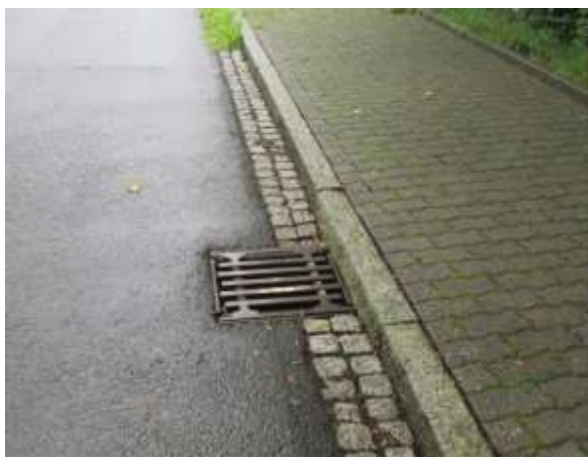
Abb. 29 saniertes Wege- und Straßenbereich an der nördlichen Seite der zentralen Grünfläche
