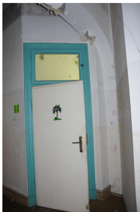
Flurbereich mit vermauerter Bogenöffnung
