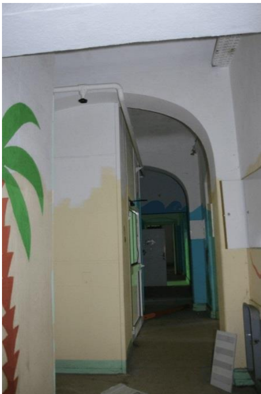
Flurbereich mit vermauerter Bogenstellung / Blickrichtung Ost
