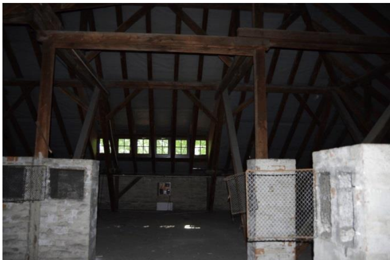
Ansicht Dachraum mit abgebrochenen Schornsteinköpfen
