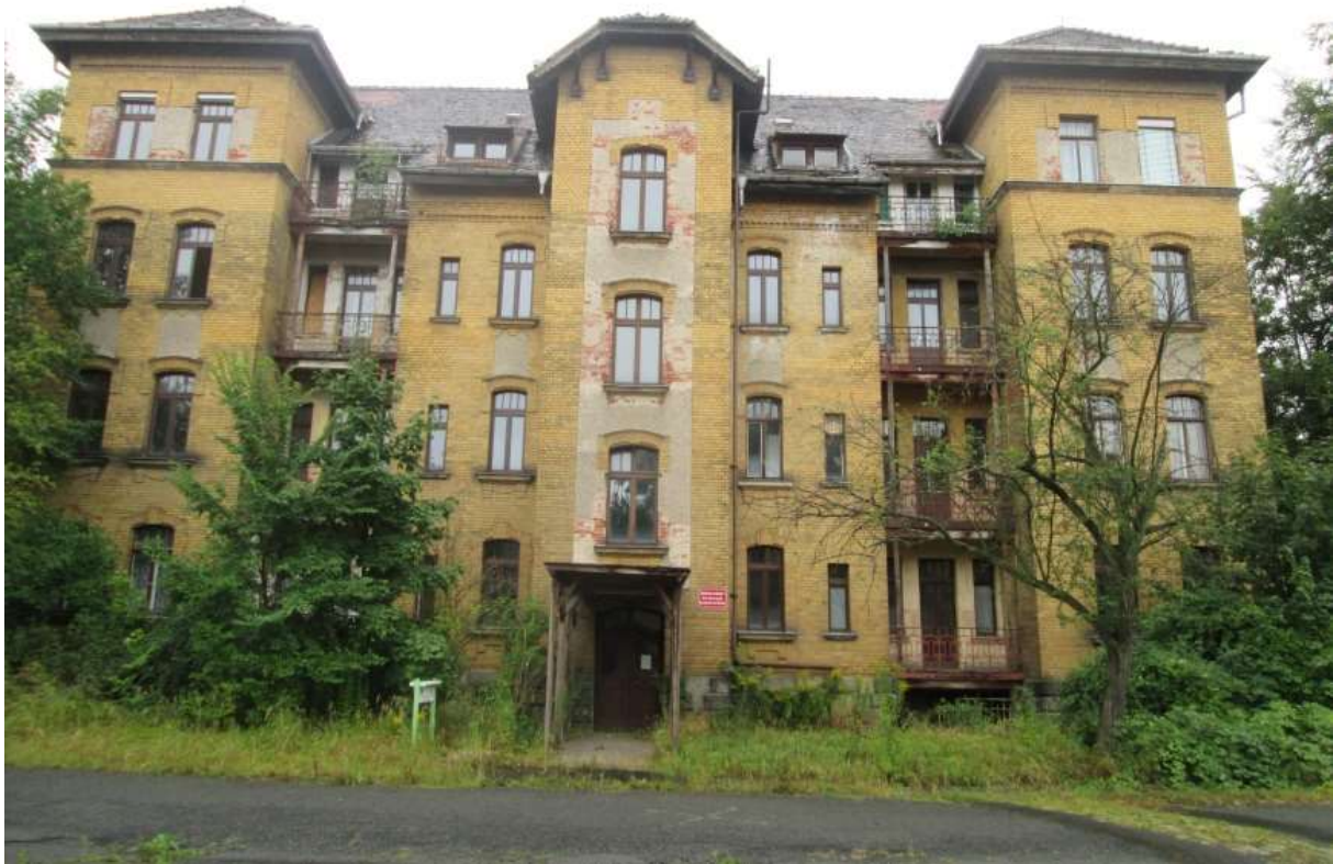
Abb. 4 verlassenes ehemaliges Ärztehaus
