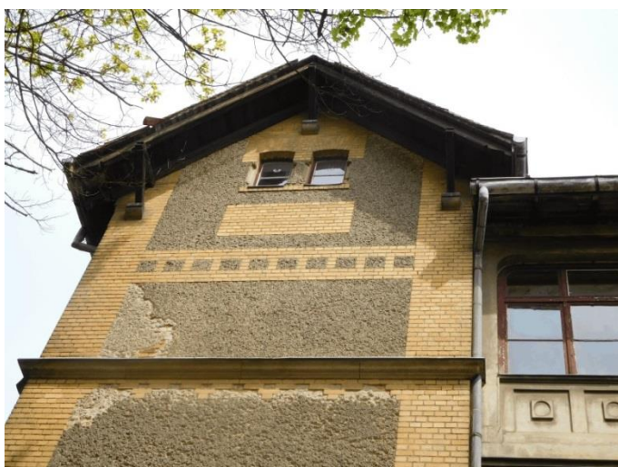
Südfassade / Westtrakt Detail
