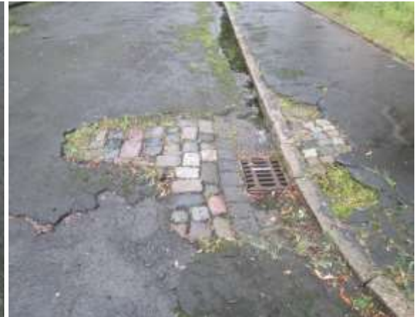
Abb. 28 Pflaster unterhalb der Asphaltdecke
