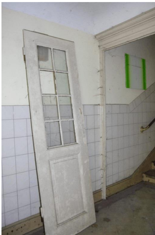
bauzeitlich erhaltene Türkonstruktion am Windfang zum Treppenlauf
