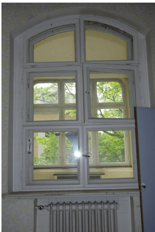
Detail bauzeitlich erhaltene Fenster
