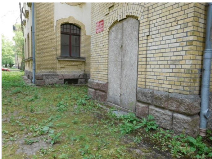
Nordfassade/ Detail Mittelrisalit Socket und EG
