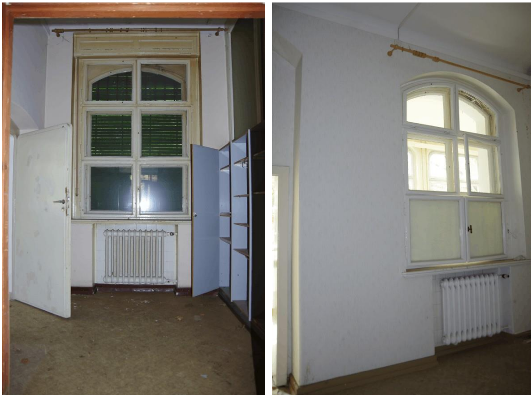
Innenraum mit z.T. modernen Einbauten und bauzeitlich erhaltenen Kastenfenstern mit Markisenkästen und Mechanik
