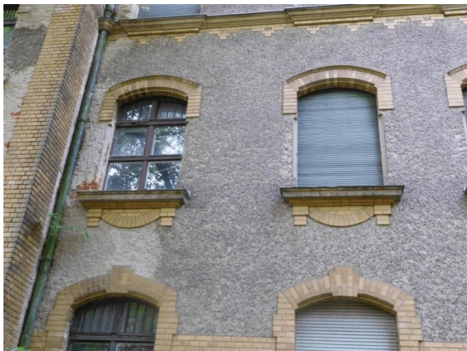
Nordfassade Westtrakt / Detail
