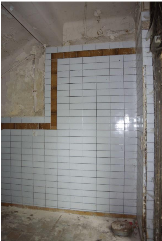
Vestibül / vermutlich bauzeitlicher Fliesensockel
