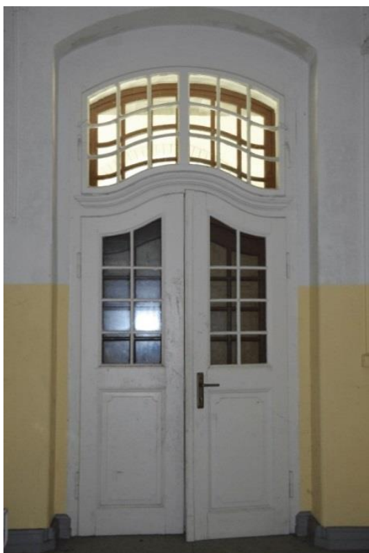
Vorraum Veranda mit bauzeitlich erhaltener Veranda - Innentür
