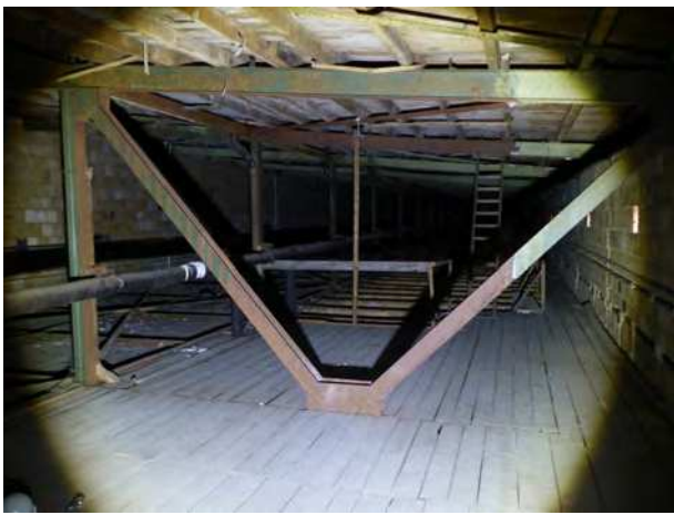
Dachboden Halle 17, keine Einflugmöglichkeiten, ohne Befund
