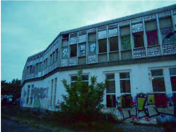
Mauersegler Nistplätze morgens, Halle 21
