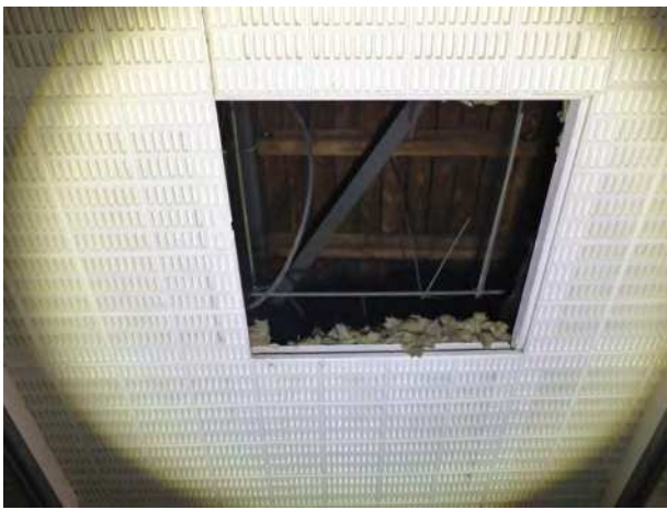
Halle 21, Zwischenboden mit Dämmwolle : pot. Fledermausquartiereigenschaften
