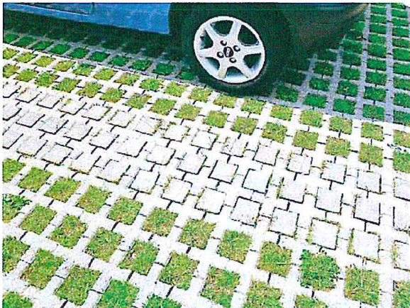
Abbildung 1: Pflastervarianten mit hohen Versickerungsmöglichkeiten.
