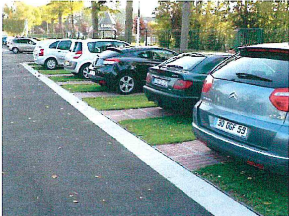
Abbildung 1: Pflastervarianten mit hohen Versickerungsmöglichkeiten.
