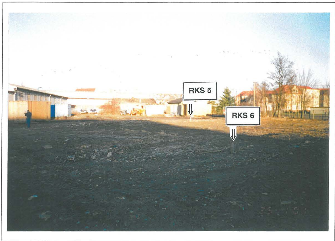
Bild 5: Blick in nordöstliche Richtung auf den Bereich des ehemaligen Silostandes mit den Probenahmestellen RKS 5 und 6 .
