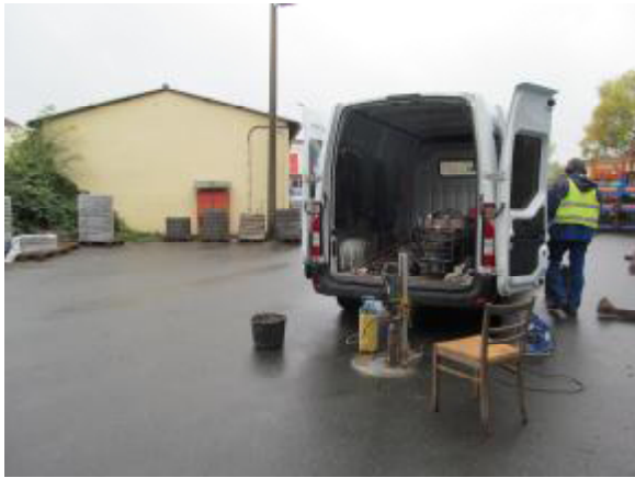
Bild 01: KRB 1, Blick nach Nordwesten, südöstlichster Bereich der Flurstücks 230b
