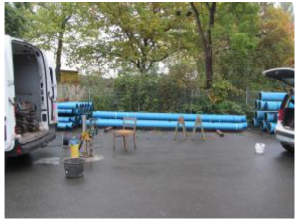
Bild 02: KRB 1, Blick nach Nordosten, südöstlichster Bereich der Flurstücks 230b
