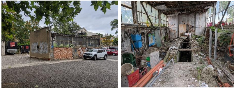
Abbildung 3: Außen- und Innenansichten des Fahrzeugschuppens.
