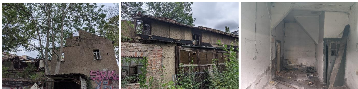
Abbildung 10: Außen- und Innenansichten des Werkstattgebäudes.
