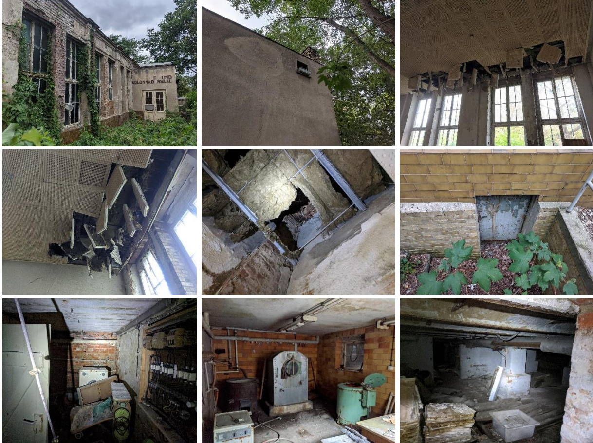
Abbildung 8: Außen- und Innenansichten des Saalgebäudes mit Keller.
