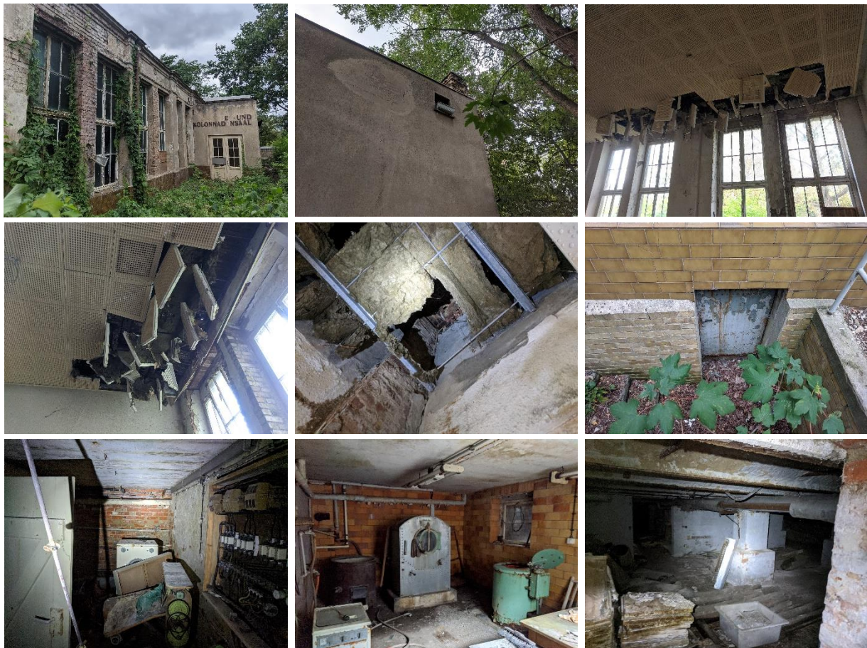
Abbildung 3: Außen- und Innenansichten des Saalgebäudes mit Keller.
