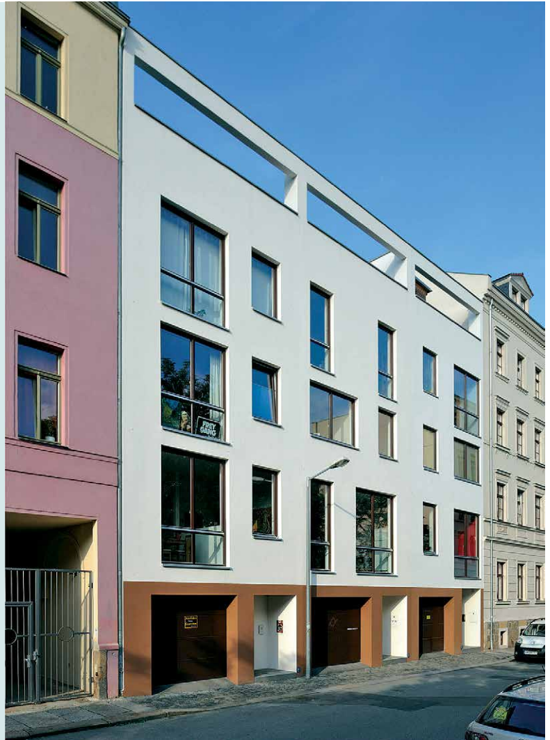
Stadthausbebauung in der Paul-Grüner-Straße, Zentrum Süd
