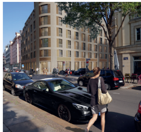
Das realisierte Objekt (oben)
