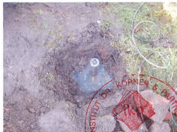
Abbildung 12: seitlicher Wasserzulauf innerhalb der Schurfgrube Aufschluss 6
