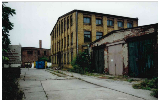
Foto 16: Holzhäuser Straße 102, 104 (Innenbereich), Anfangsqualität undatiert
