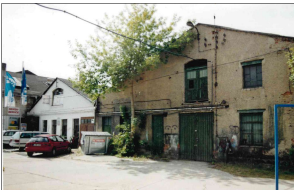
Foto 15: Holzhäuser Straße 102, 104 (Innenbereich), Anfangsqualität undatiert
