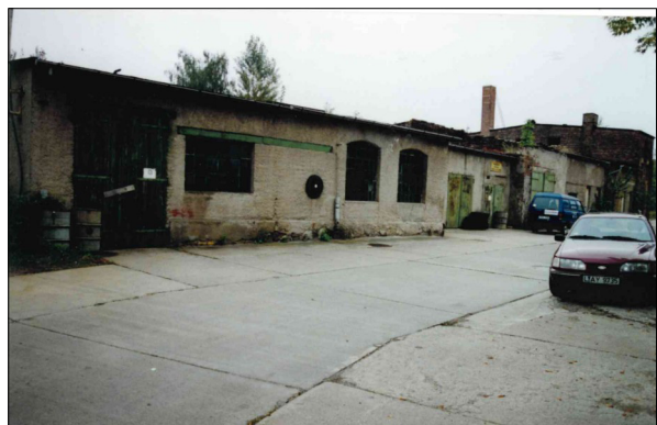
Foto 18: Holzhäuser Straße 102, 104 (Innenbereich), Anfangsqualität undatiert
