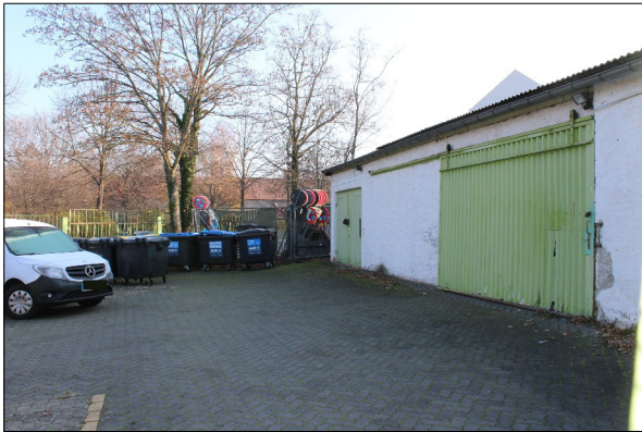
Foto 42: Lange Reihe Zwischennutzung Block 1, Endqualität 2020
