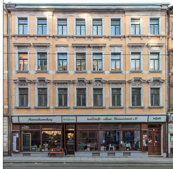
Foto 21: Georg Schwarz Straße 7 nach Sanierung; undatiert; Regentaucher | Fotografie
