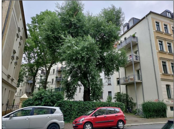
Foto 41: Rückansicht Merseburger Straße 118 und Calvisiusstraße 41; 2021
