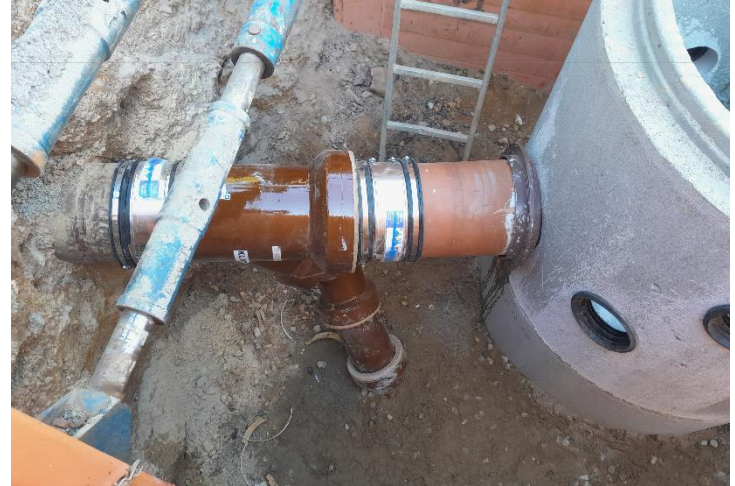
Erneuerung Abwasserschacht
