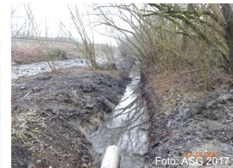
Entfernung Rasengitterplatten zur ökologische Aufwertung
