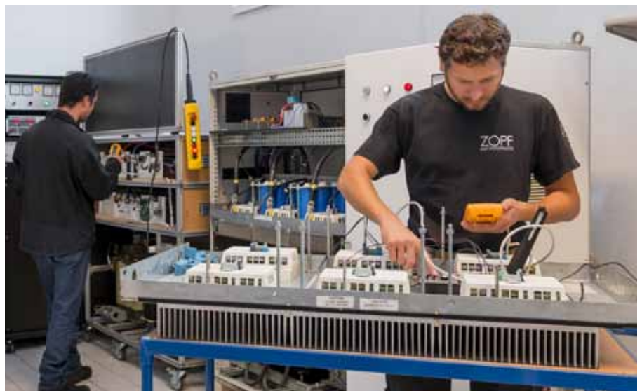
Instandsetzung eines Frequenzumrichters durch Mitarbeiter der ZOPF Energieanlagen GmbH. Quelle (2): ZOPF Energieanlagen GmbH
