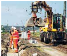
Bauarbeiten vorm Leipziger Hauptbahnhof
