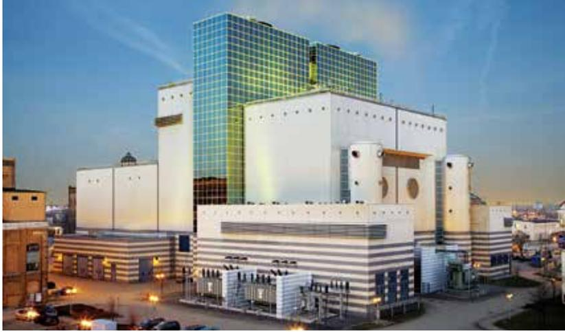
Strom und Wärme erzeugen die Leipziger Stadtwerke in ihrer umweltschonenden und effizienten Gas- und Dampfturbinenanlage in Kraft-Wärme-Kopplung und mittels erneuerbarer Energien aus Biomasse und Wind.
