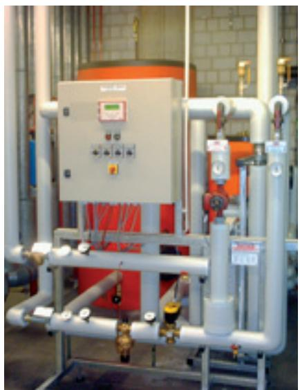
ENERelektronik, Steuerung für Trinkwassererwärmung mit thermischer Desinfektion
