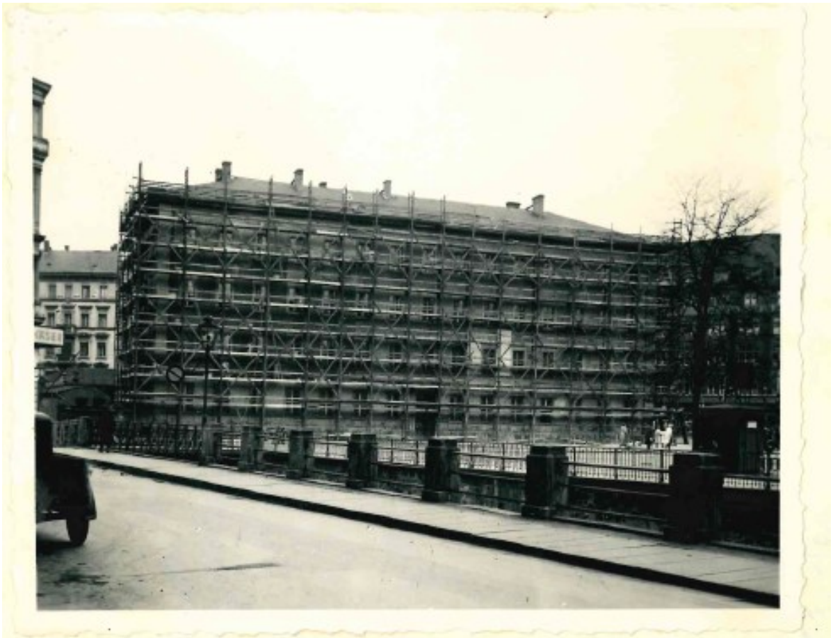
Unser Haus erhält ein neues Kleid... (Photo Spindler) –
