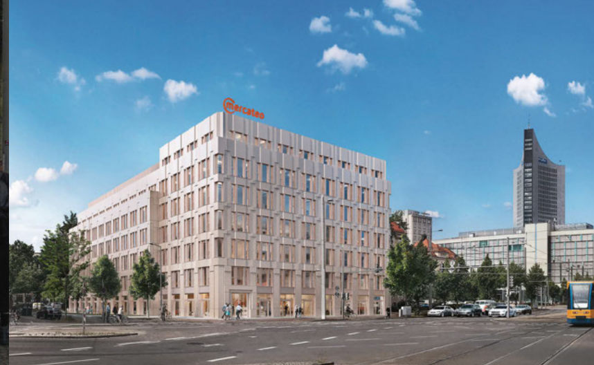
Der Büroreubau mit dem Namen „NETZWERK“ wird ab 2023 neuer Hauptsitz von Mercateo.
